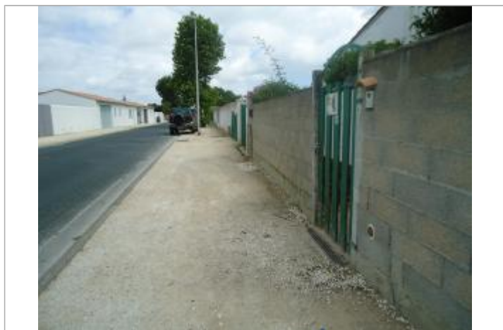
Repère Xynthia - Avenue du Moulin des sables
