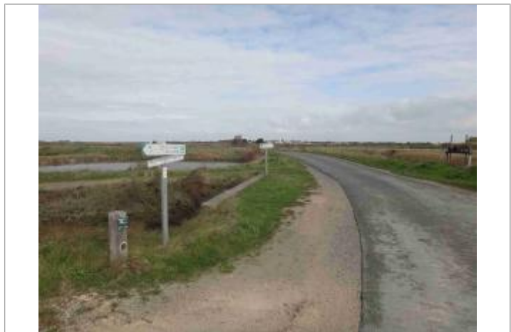
Repère Xynthia - Piste Cyclable - Dieppe/ Les Levées neuves
