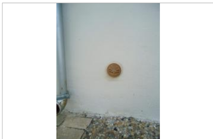
Repère Xynthia -Rue du Ventoux
