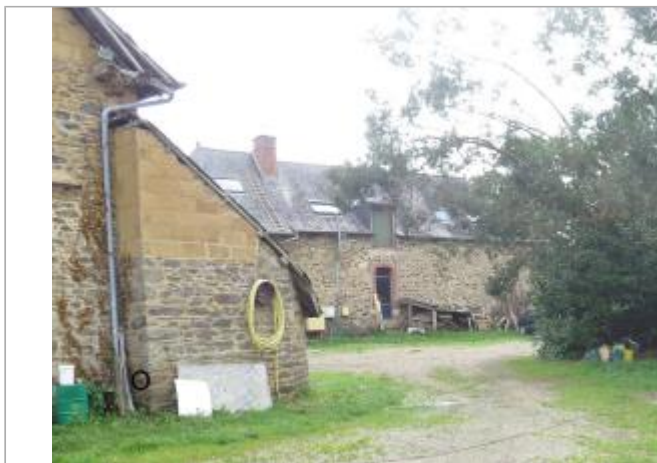
repère de crue 1966 sur bâtiment exploitation agricole
