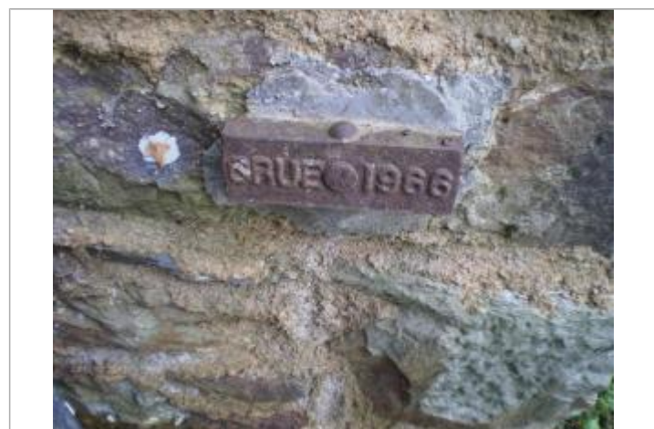
Repère de crue d'octobre 1966 sur bâtiment agricole
