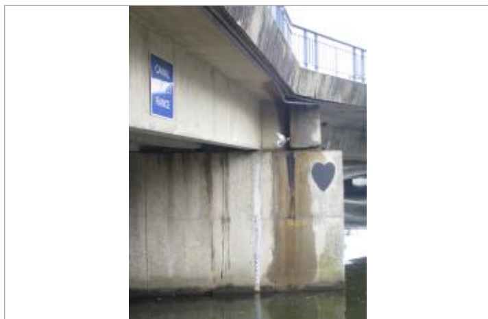
Echelle limnimétrique en aval de l'écluse du Mail
