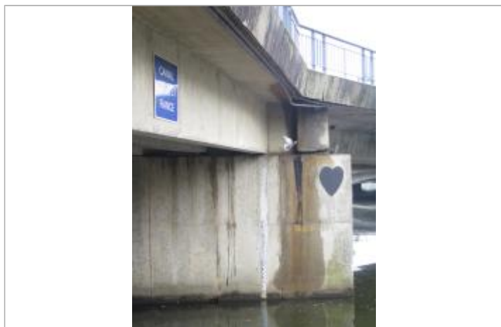
Echelle limnimétrique en aval de l'écluse du Mail
