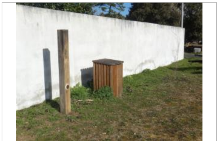
Repère Xynthia - aire de pique nique rue Charbonnière
