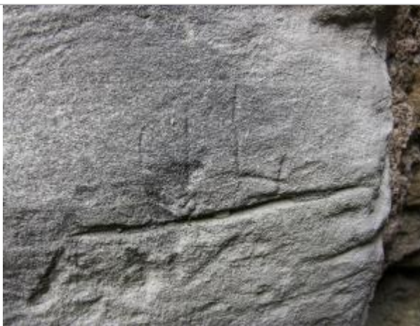
Marque 1994 - couloir intérieur côté rivière
