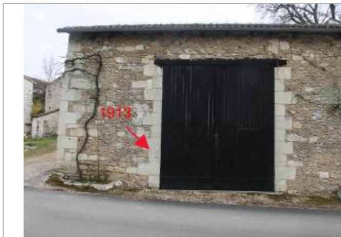
Entrée de la grange - 9 rue du port de Ribes
