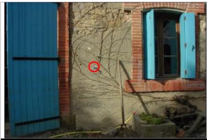
Mur de façade de maison
