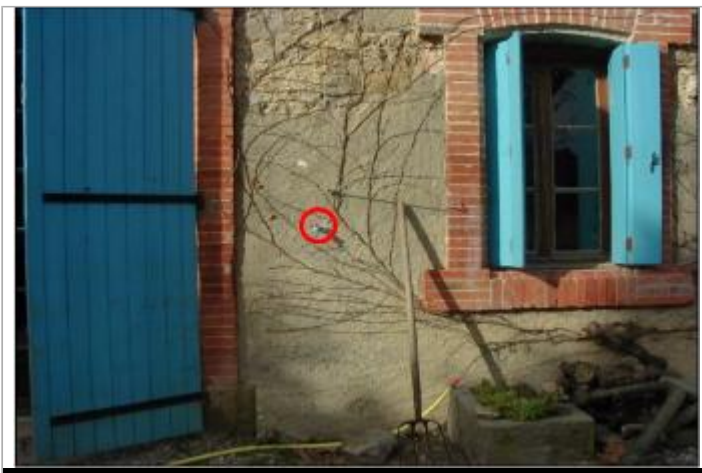
Mur de façade de maison
