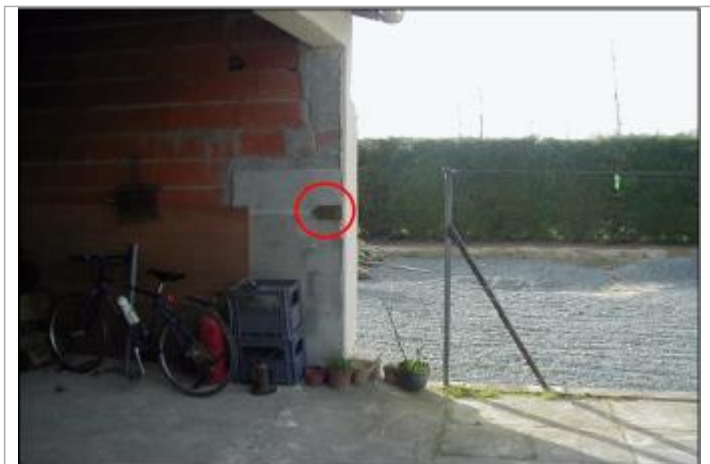
Mur du Garage
