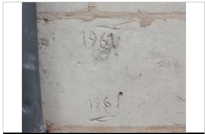
Marques indication 1961 (potentielles crue de 1962)
