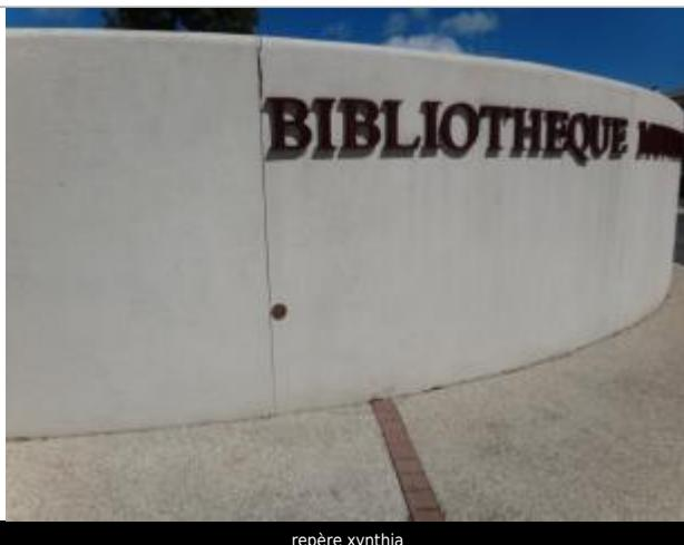
**NIVELLEMENT INITIAL - 24/06/2014****Méthode :** GPS**Commentaires sur le nivelllement :** nivelllement réalisé par un géomètre expert**Référence nivellée :** Marque d'inondation**Système altimétrique :** NGF IIGN 1969 (système normal)**Altitude de la référence (en m) :** 4.200 m**Altitude calculée de l'eau (en m) :** 4.2 m
