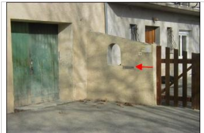
Mur de séparation
