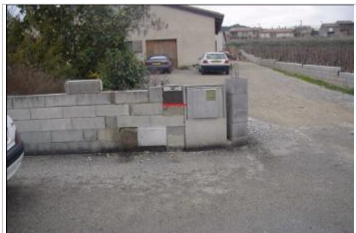
Mur de clôture
