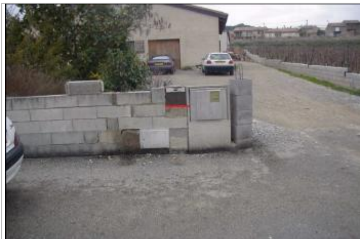
Mur de clôture
