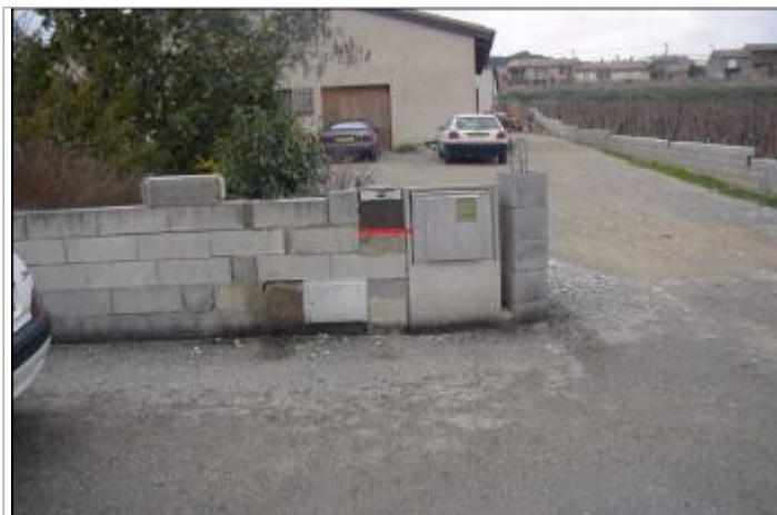
Mur de clôture
