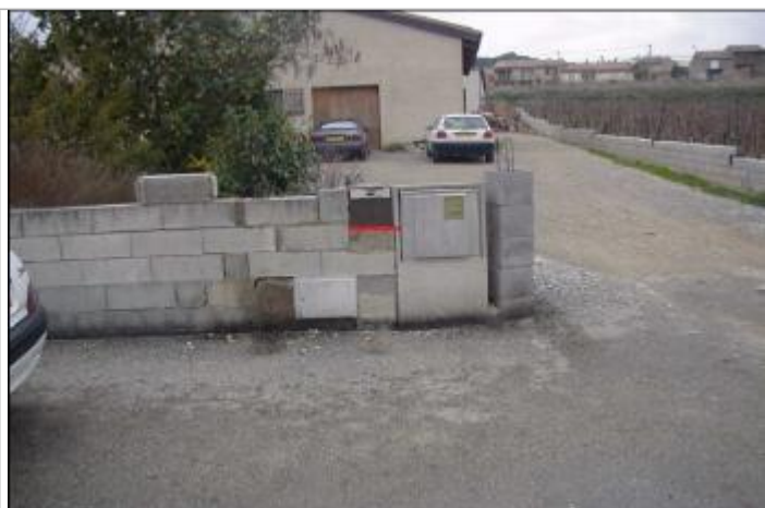
Mur de clôture
