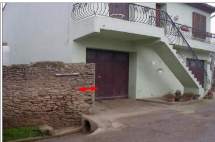
Mur de clôture
