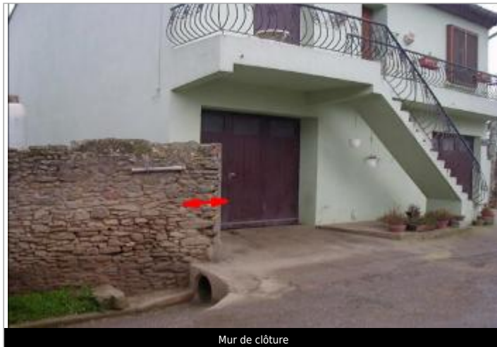
Mur de clôture
