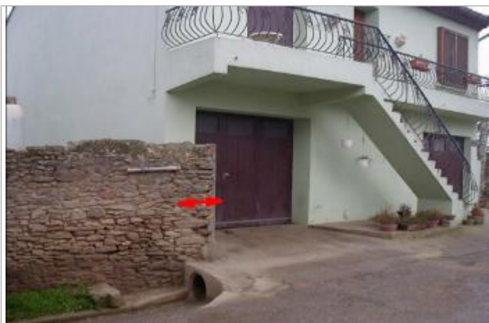
Mur de clôture
