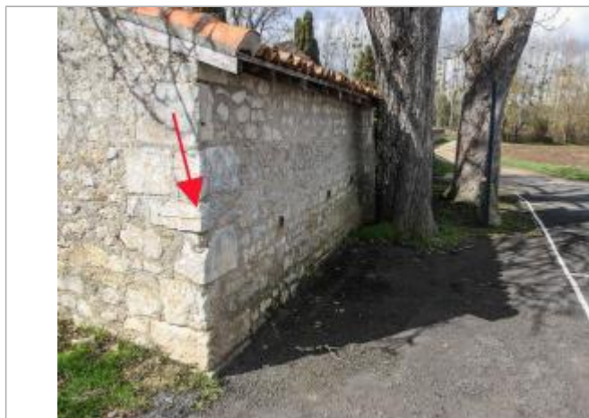
Photographie repère crue 1896 - façade mur église
