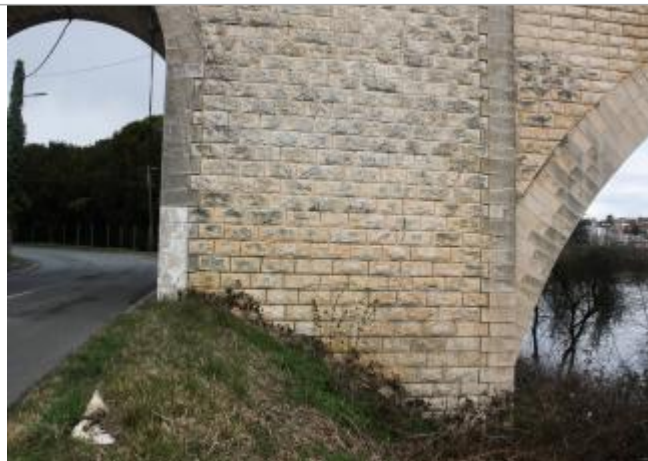
Pont de l'ancienne voie ferrée - pile en rive gauche face amont
