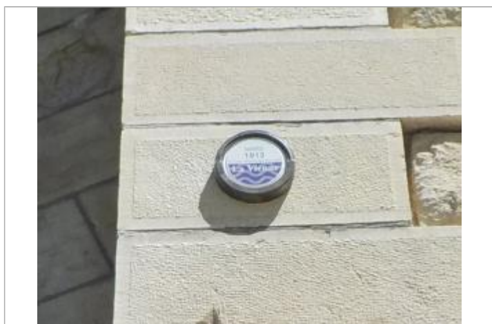
Photos du repère CHAU17-R. Source : 3DI
