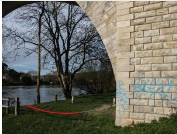
Pont de l'ancienne voie ferrée - pile en rive droite face amont
