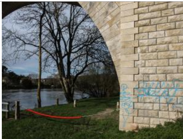
Pont de l'ancienne voie ferrée - pile en rive droite face amont
