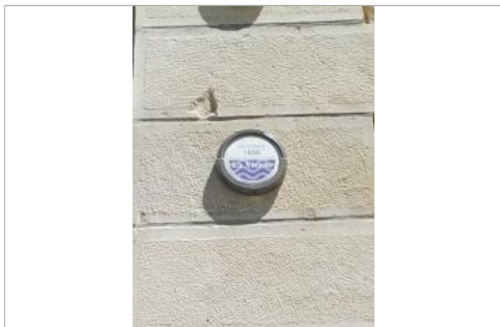
Photos du repère CHAU16-R. Source : 3DI
