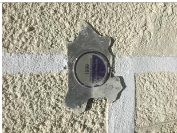
Façade du bâtiment
