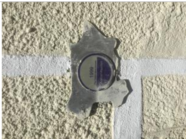
Façade du bâtiment
