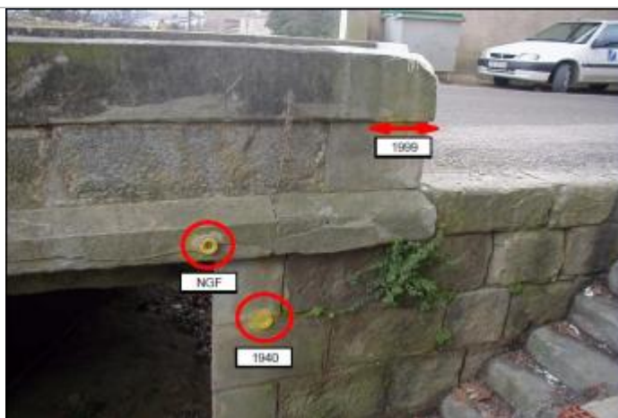
Parapet du pont amont
