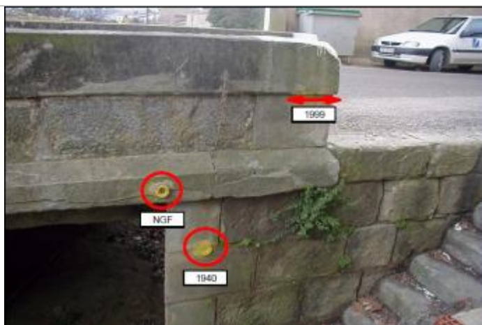
Pont RD 111 - Parapet amont
