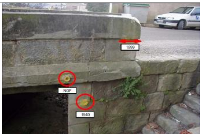
Parapet du pont amont
