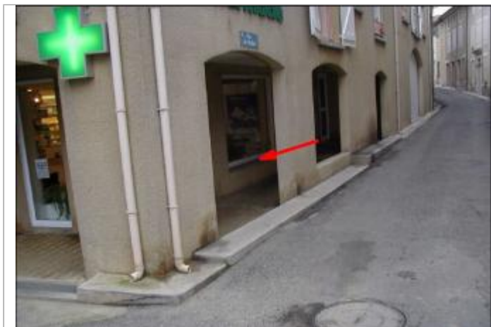
Seuil de fenêtre - Façade d'entrée
