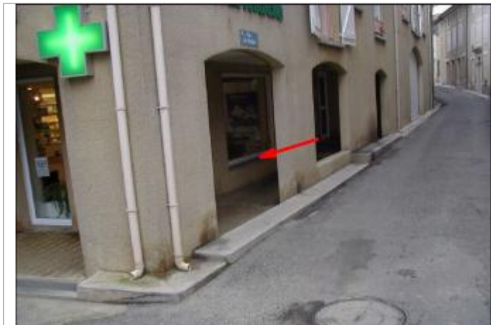
Seuil de fenêtre - Façade d'entrée
