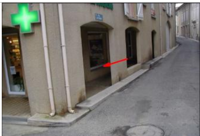
Seuil de fenêtre - Façade d'entrée de la pharmacie
