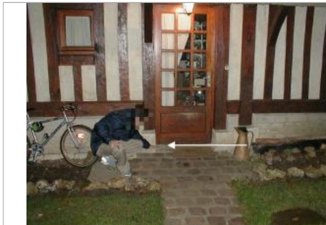
5 cm d'eau au-dessus du sol au niveau de l'entrée de la maison (Source: SAFEGE)
