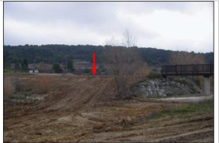
Niveau haut de la digue
