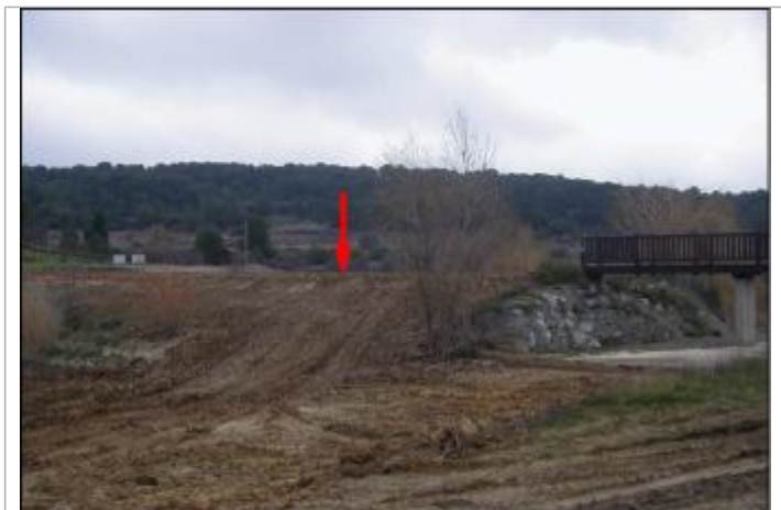
Niveau haut de la digue
