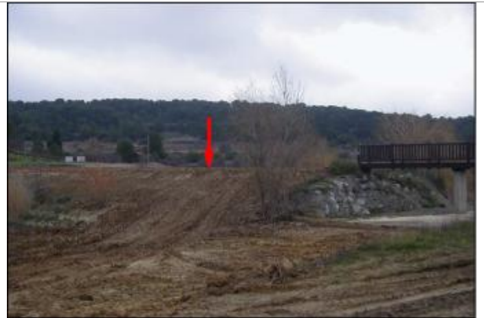
Niveau haut de la digue
