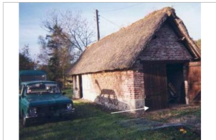
La hauteur d'eau maximale dans le garage a été de 15 cm (Source : SAFEGE)
