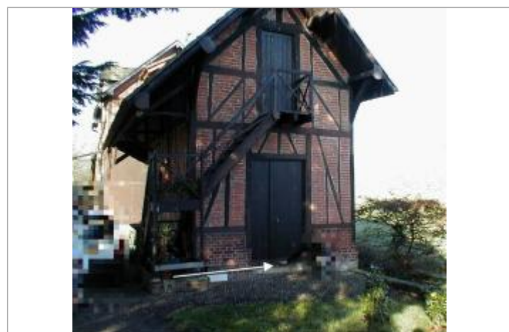
L'eau est arrivée juste en dessous du seuil de la porte (Source : SAFEGE).
