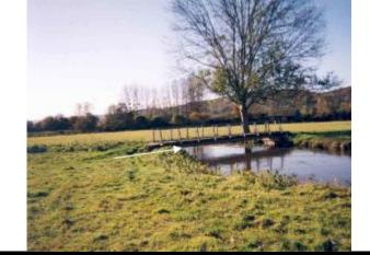
Au moment des plus hautes eaux, la passerelle s'est très légèrement mise en charge (1 cm par rapport au bas du tablier)(Source : SAFEGE).
