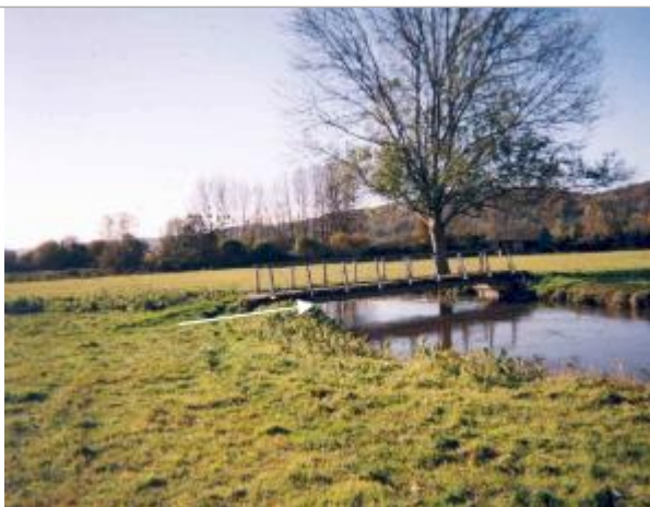
Au moment des plus hautes eaux, la passerelle s'est très légèrement mise en charge (1 cm par rapport au bas du tablier)(Source : SAFEGE).
