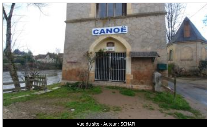
Vue du site - Auteur : SCHAPI
