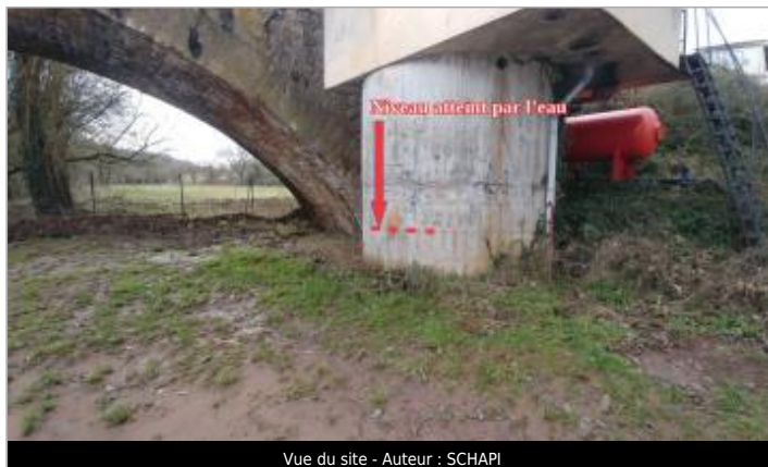
Vue du site - Auteur : SCHAPI
