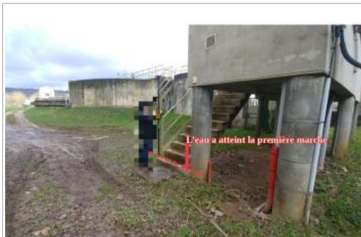
Vue du site - Auteur : SCHAPI
