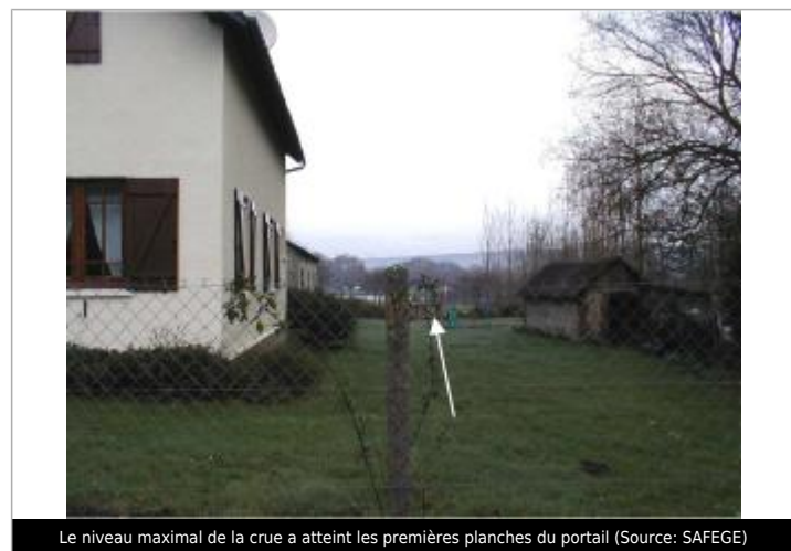
Le niveau maximal de la crue a atteint les premières planches du portail (Source: SAFEGE)
