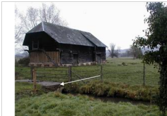
L'eau est montée en haut du tablier de la passerelle.
