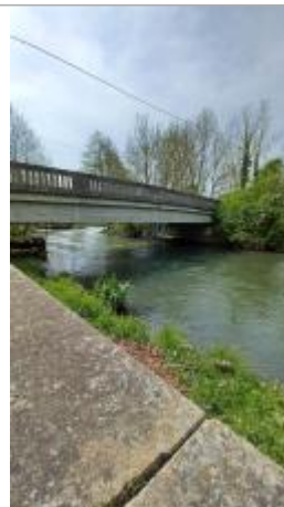
Echelle limnimétrique de la Station hydrométrique située en rive gauche du pont de la RD137 sur la Risle.
