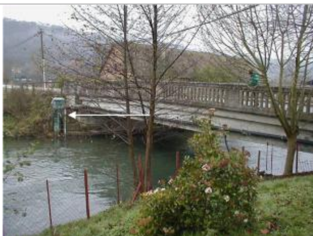
La hauteur d'eau maximale, enregistrée à la Banque HYDRO, est de 1650 mm (Source : SAFEGE)
