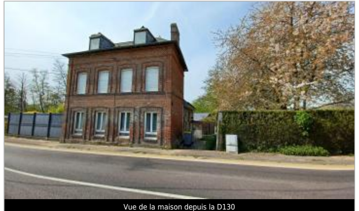
Vue de la maison depuis la D130
