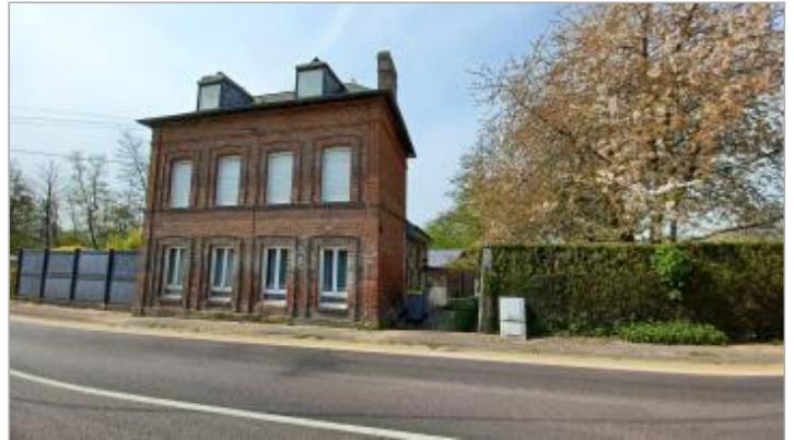
Vue de la maison depuis la D130
