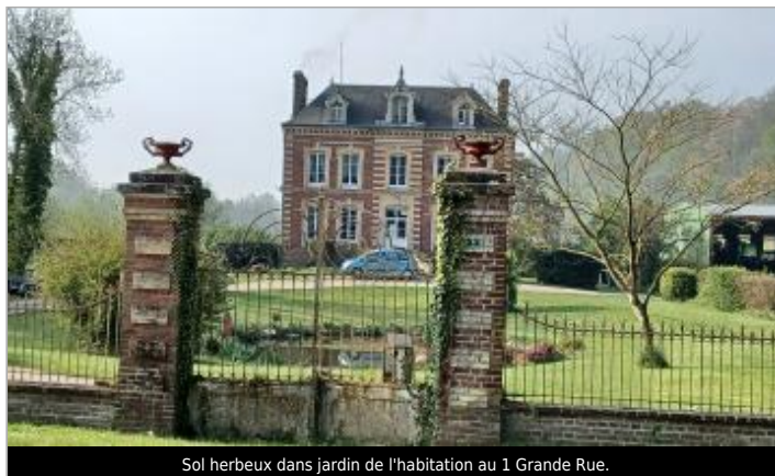
Sol herbeux dans jardin de l'habitation au 1 Grande Rue.
