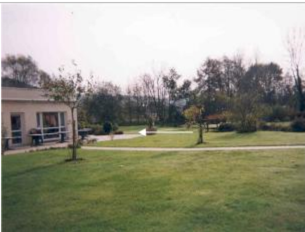
Le bout de la terrasse était recouvert par environ 5 cm d'eau (Source: SAFEGE)
