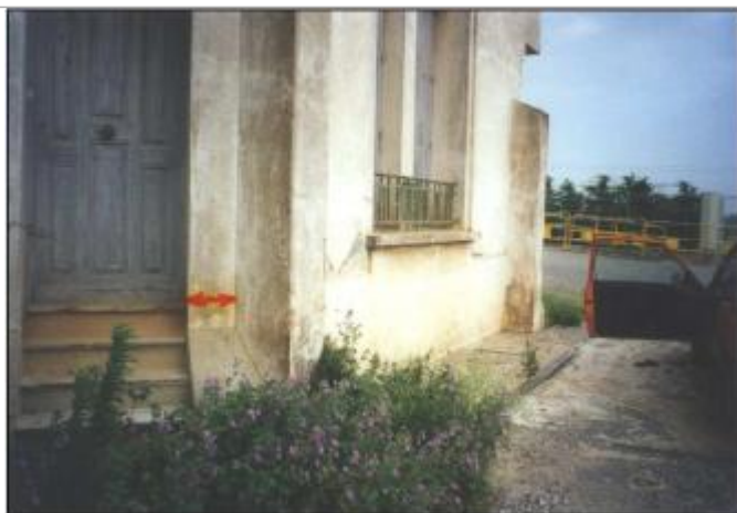
Mur de façade de la distillerie
