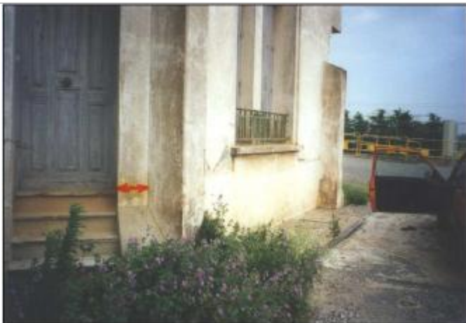
Mur de façade de la distillerie
