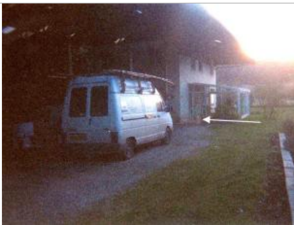
L'eau est arrivée environ 1 cm au-dessus de la marche de la véranda (Source : SAFEGE)
