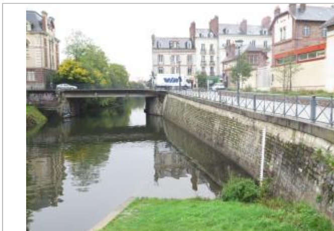
Vue générale du site de l'échelle limnimétrique en aval du clapet dit du cabinet vert
