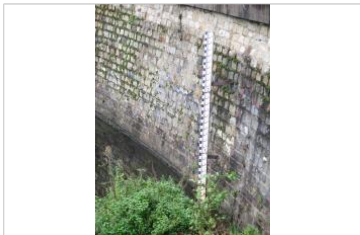
Echelle limnimétrique en aval du clapet dit du cabinet vert à Rennes
