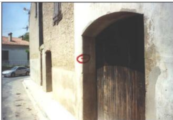
Mur de façade garage
