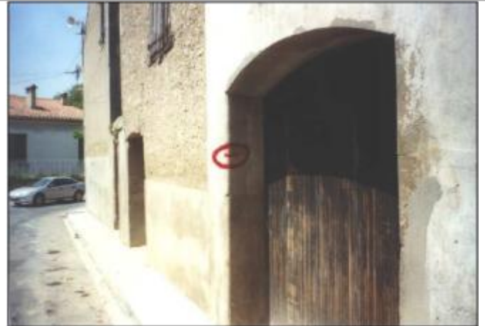
Mur façade de garage
